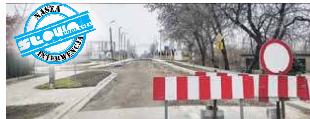
Jak przypomina mieszkaniec Terespoli przejazd kolejowy miał być wyremontowany do 28 października, prace nie zostały ukończone do dziś
