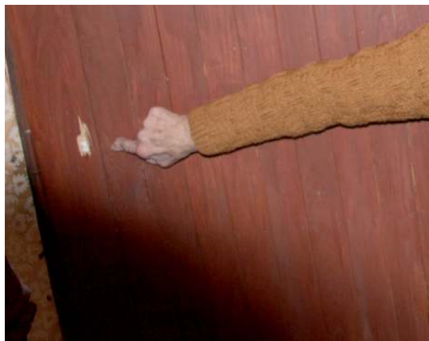
Otwór wylotowy po wewnętrznej stronie drzwi
