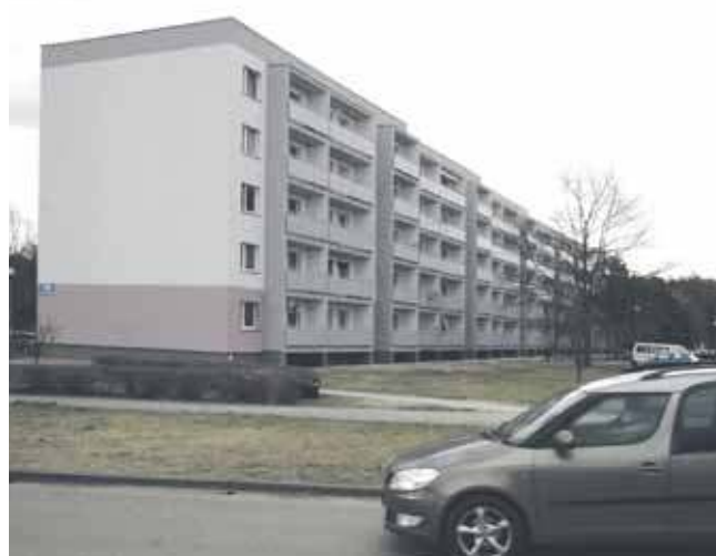
Z budynku przy ul. Armii Krajowej 16 zdemontowano ocieplenie azbestowe, a potem poddano go termomodernizacji
