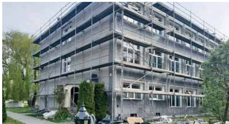
Prace w Zielonej mają być zakończone po wakacjach
