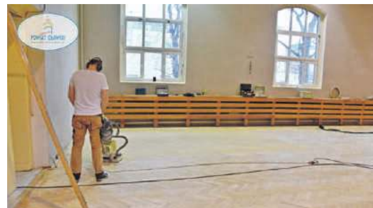
Trwa naprawa nawierzchni sali gimnastycznej w Ogólniaku
