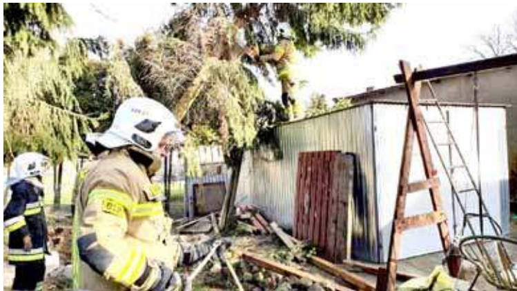
Strażacy usuwali również połamane drzewa w miejscowości Parliń. Foto. OSP. Parliń
