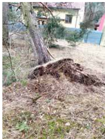
W miejscowości Jęczydół drzewo niebezpiecznie przechyliło się na budynek mieszkalny. Foto. OSP. Kobyłanka
