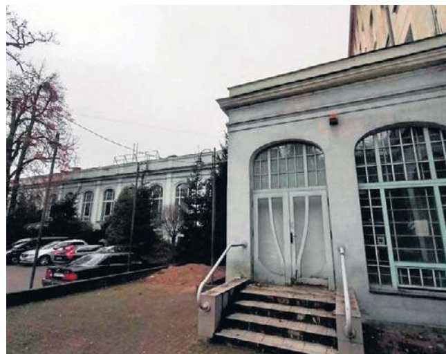
Teatr Polski od lat zabiegał o przekazanie budynku dawnego kasyna u zbiegu Al. Mickiewicza i Gdańskiej
