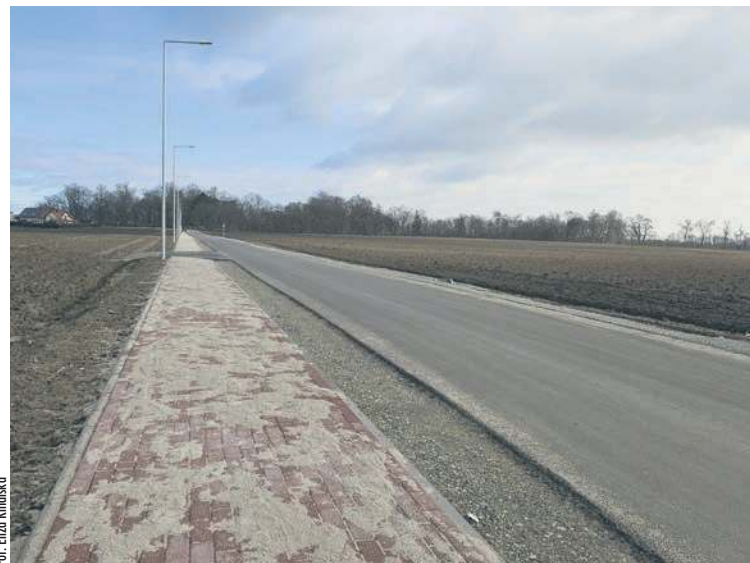
W ramach inwestycji oprócz nowej nawierzchni wykonano także m.in. chodniki i oświetlenie
