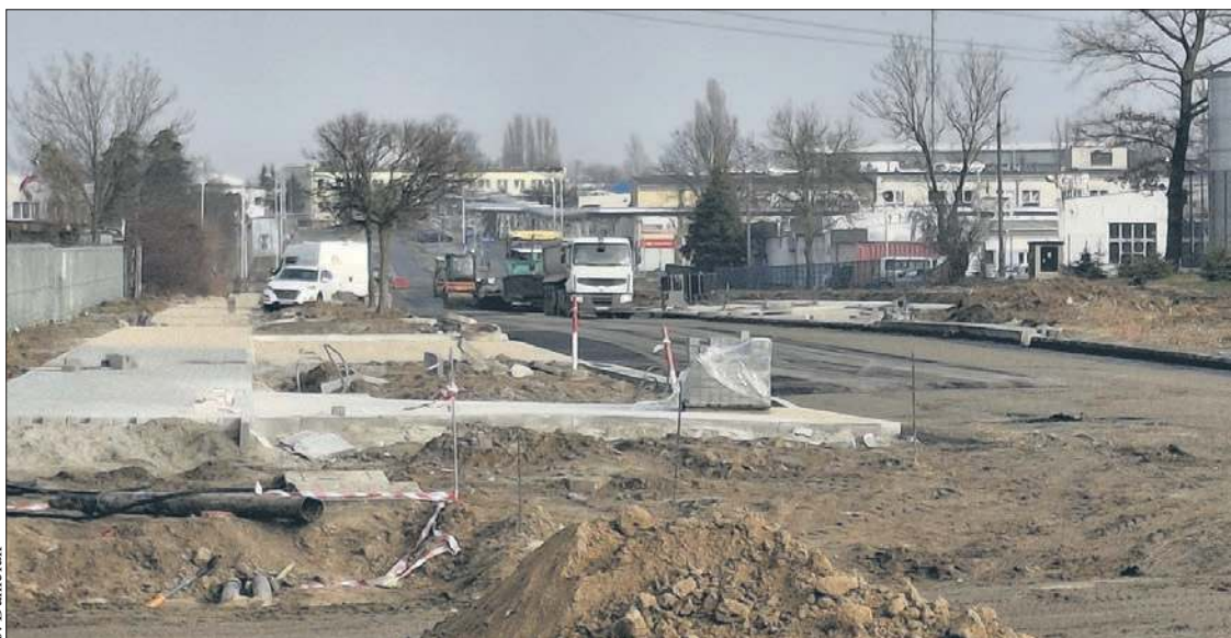
Rozpoczęło się układanie pierwszej warstwy asfaltu na kolejnym fragmencie przebudowywanej ulicy Przemysłowej
