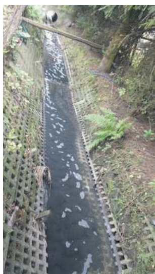
Pstrużnikiem wciąż płynie brudna i spieniona woda
