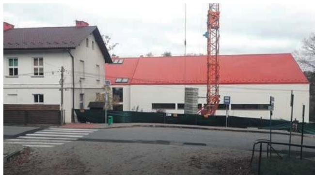
Tak wygląda obecnie sala gimnastyczna, dobudowana do starej podstawówki w Grojcu
