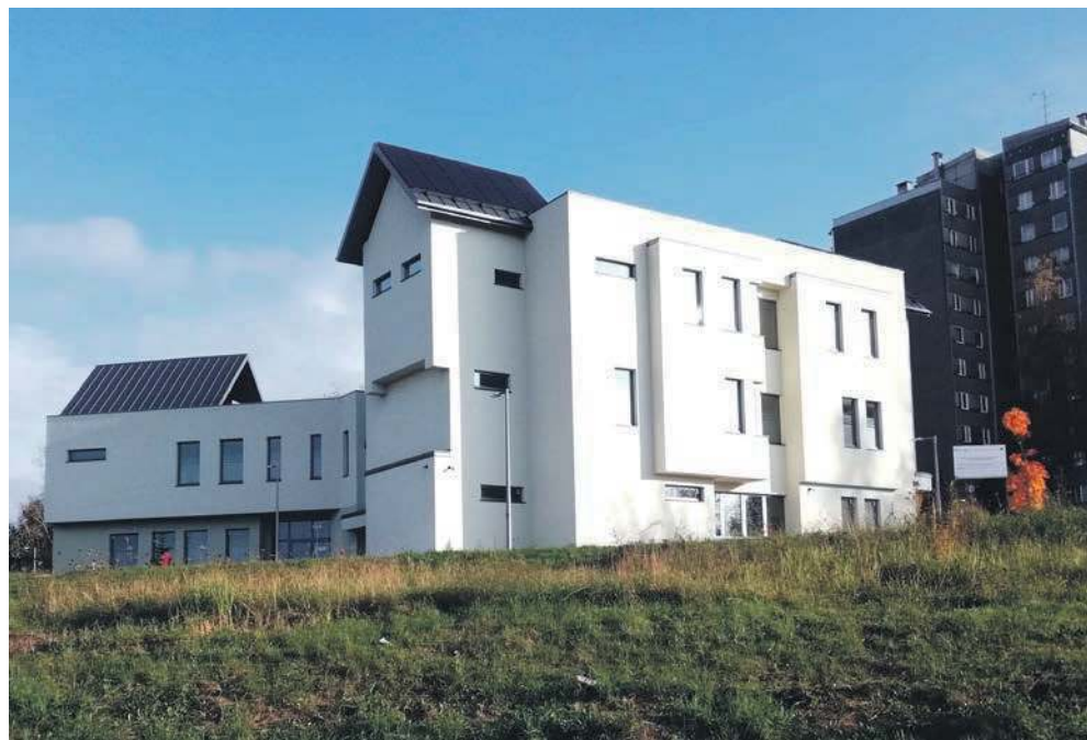
Prezes ZLA podjął się budowy nowej przychodni na osiedlu Południe w czasach, kiedy kierowana przez niego spółka nie była w tak dobrej sytuacji finansowej jak obecnie
