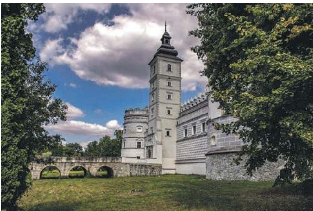
Widok zamku od strony mostu wiodącego do wieży zegarowej
