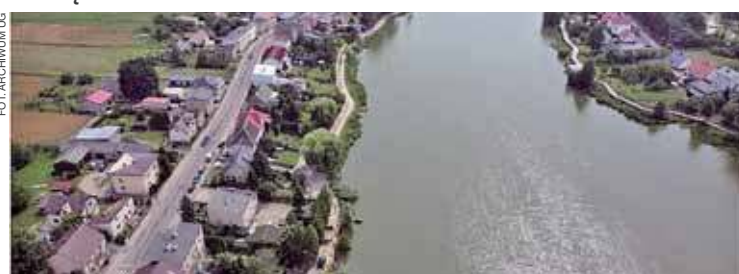
Aktualny stan inwestycji z lotu ptaka
