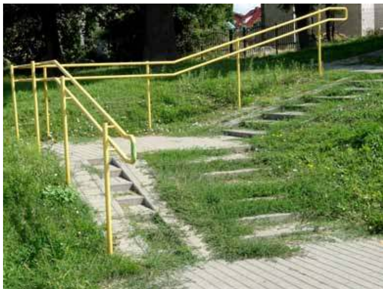
Tylko poręcze sygnalizują, że tu są schody
