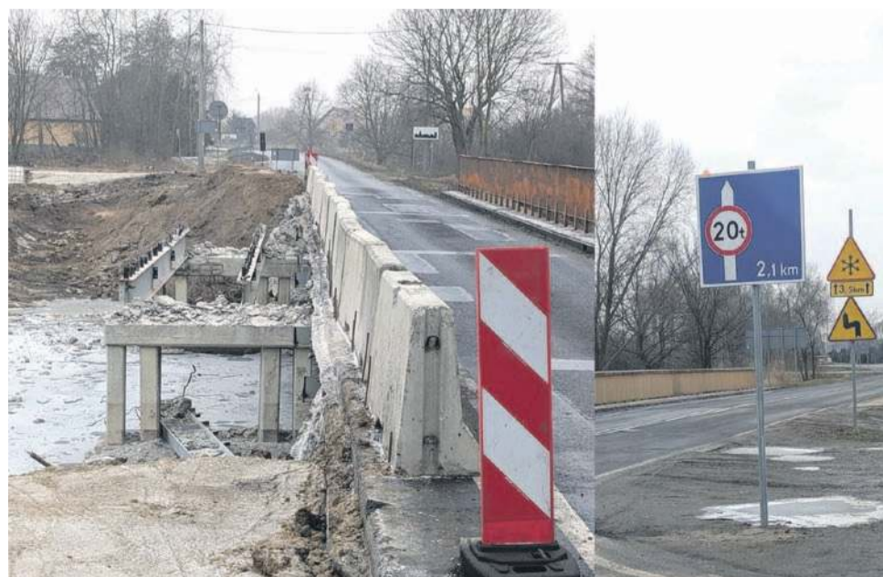
Trwa przebudowa dwóch mostów w okolicach Starego Górnika
