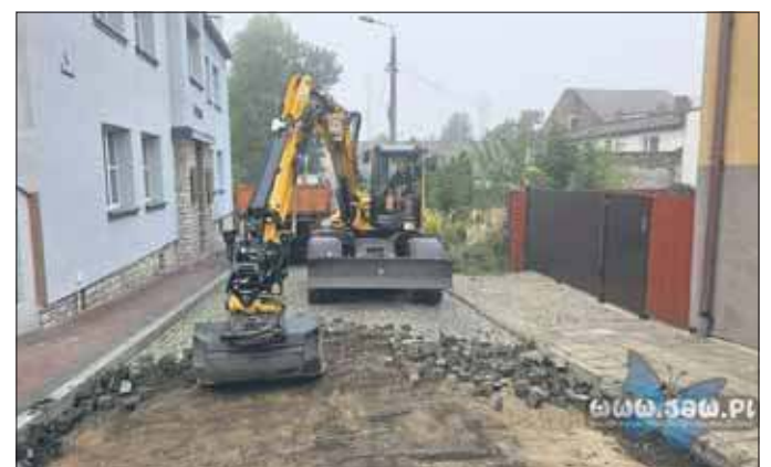
Ulica Biała, Jaworzno. Wymiana kostki brukowej na asfalt
