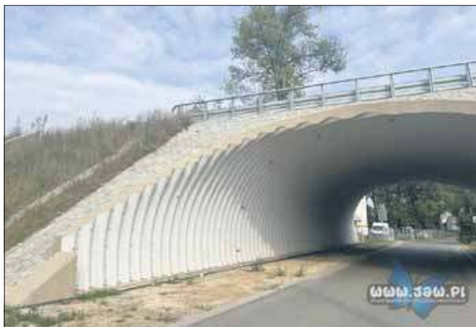
Nasyp wiaduktu w Ciężkowicach
