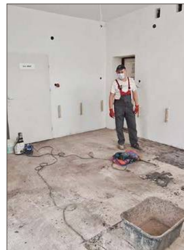
Prosektorium jest remontowane.
