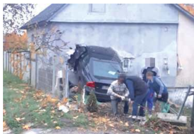
Samochód z impetem wjechał dom. Siła uderzenia była tak duża, że auto przebiło ścianę budynku
