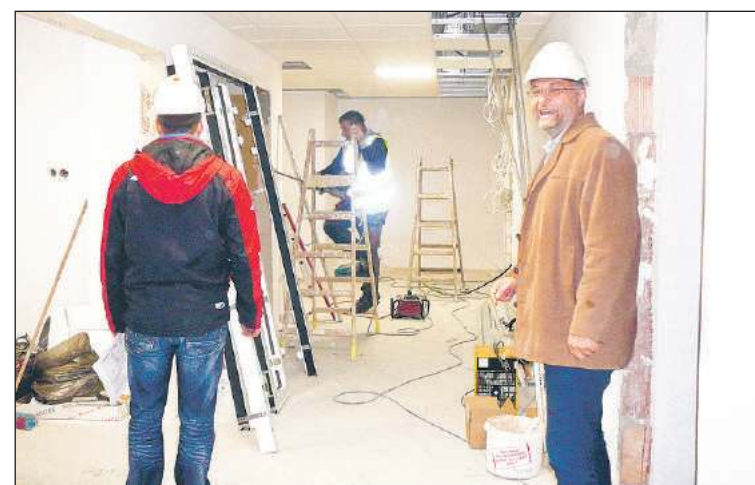
- Budowa bloku operacyjnego trwa i nie jest w żaden sposób zagrożona - mówi Przemysław Wojtys, dyrektor Zespołu Opieki Zdrowotnej w Dębicy.
