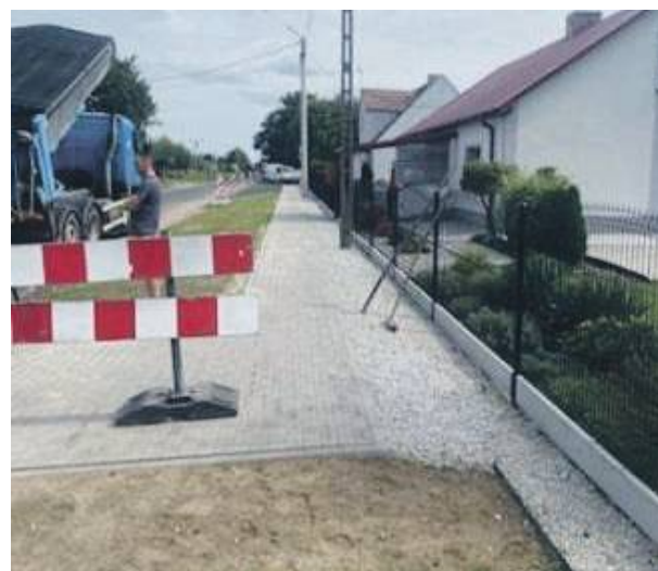
W Gułowie trwają prace związane z budową chodnika przy drodze powiatowej
