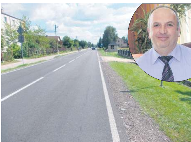
Po remoncie droga na odcinku Długi Kąt – Józefów ma jednolitą szerokość jezdni (6,10 m).
