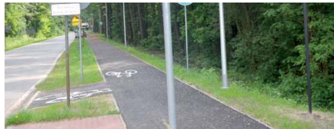
Dobiegła końca budowa ścieżki rowerowej z oświetleniem w pasie drogi powiatowej z Ciechanek do Ostrówka, dofinansowana kwotą ponad 1 mln zł z Regionalnego Programu Operacyjnego Województwa Lubelskiego. To była latami wyczekiwana inwestycja, konieczna dla bezpieczeństwa na tej bardzo uczęszczanej przez rowerzystów, pieszych i uczniów drodze.
