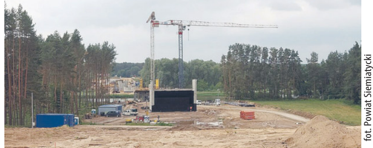
Budowa mostu Krzemień – Granne
