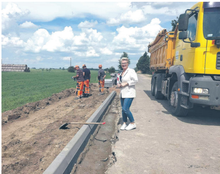
Beata Jerzman, wójt Starej Kornicy , osobiście dopilnowuje remontu drogi w Kobylanach. fot. UG w Starej Kornicy
