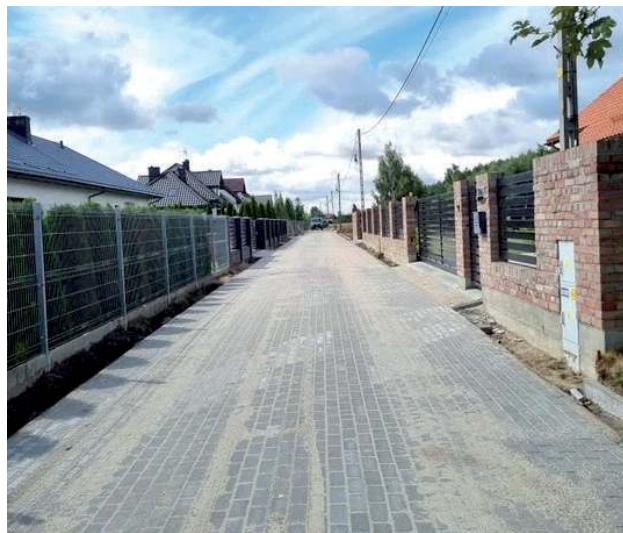
Obecnie trwa budowa ok. 500-metrowego odcinka ul. Radzyńskiej (fot. UM Łuków)
