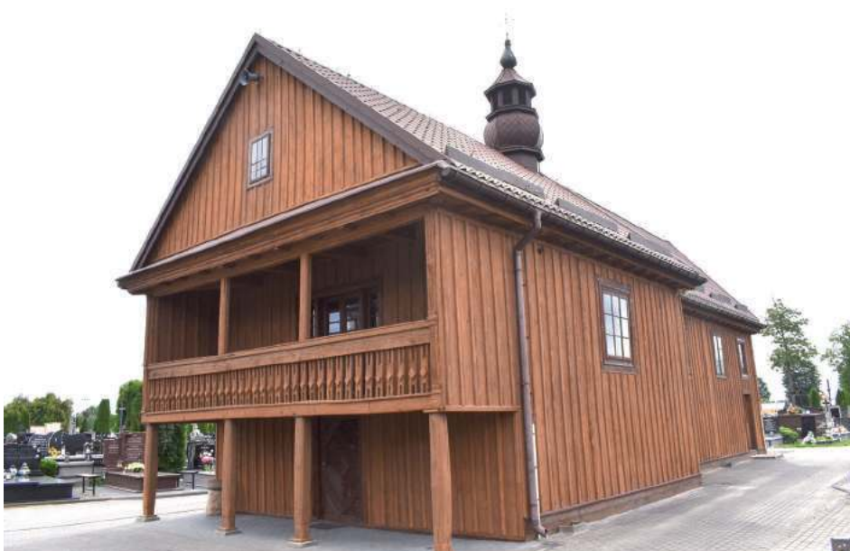
Stare nawarstwienia malarskie na drewnianym kościółku św. Rocha zostały zerwane, powierzchnia drewna oczyszczona. Kolor nowej farby elewacyjnej parafia uzgodniła z konserwatorem zabytków
