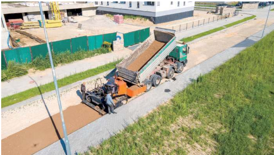
Ul. Kresów Wschodnich wkrótce zyska pierwszą warstwę nawierzchni bitumicznej (fot. UM Łuków)
