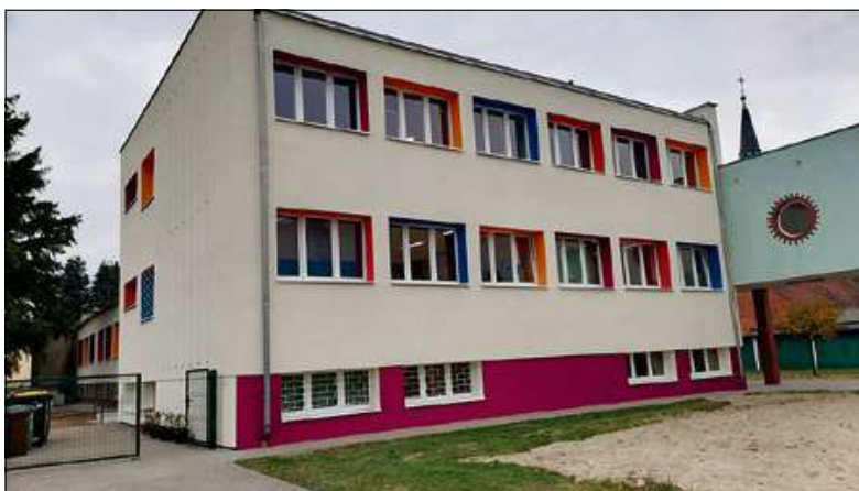
Tak prezentuje się budynek Publicznej Szkoły Podstawowej w Chrzastowicach po termomodernizacji.
