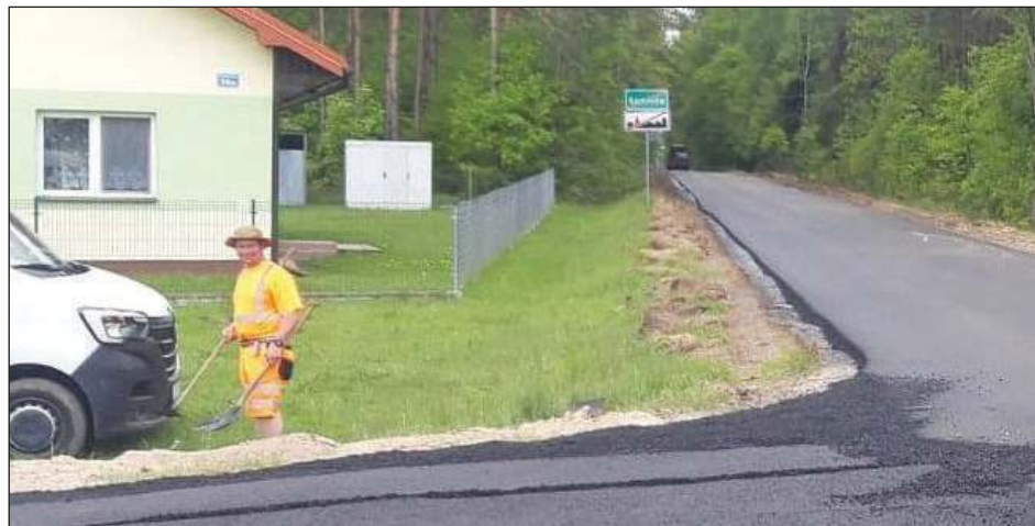
Nowy asfalt w Łomnicy pojawił się na długości 565 m. Dwie jego warstwy powinny zapewnić solidną jakość i długi okres trwałości
