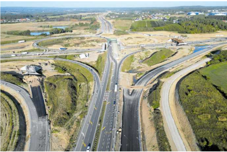
• Budowa Obwodnicy Metropolii Trójmiejskiej w sierpniu 2024
