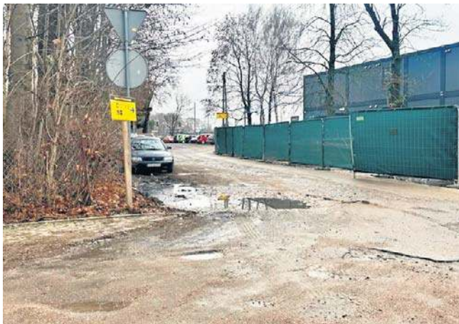
Podróżni, by dojść do peronu muszą obejść kałuże oraz dziury. Wieczorem i nocą jest to wyjątkowo niebezpieczne
