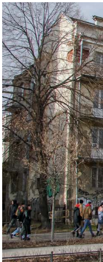
Kamienica przy ul. Grójeckiej 184 i jej zniszczona elewacja
