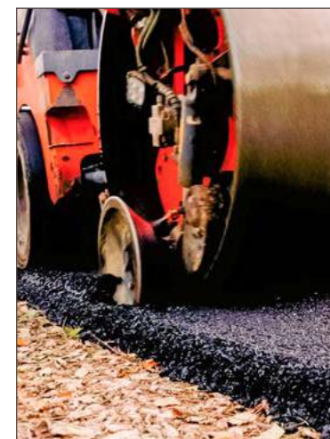
Na drodze położony zostanie asfalt.
