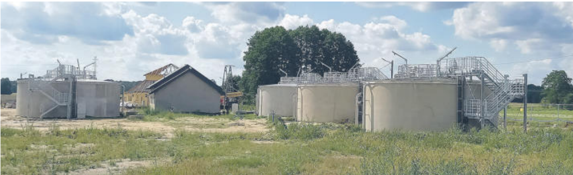
Nowa oczyszczalnia w Wiśniewie
