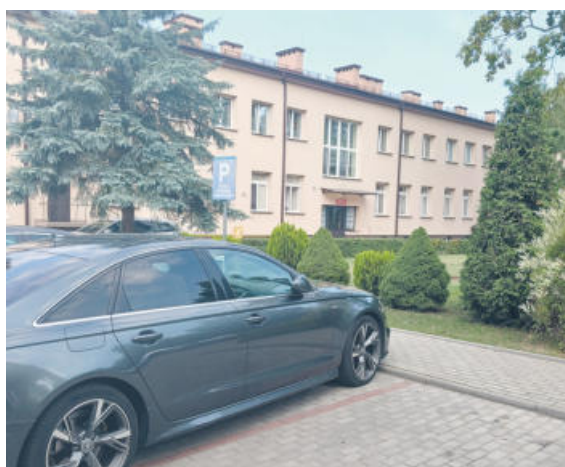
W tym budynku Ewa Mokicka chciałaby utworzyć niewielki internat.
