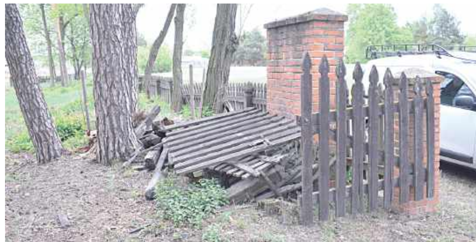
Uwaga zwraca rozwalone ogrodzenie cmentarza
