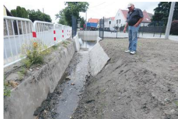
Rów i skarpa przed ujściem do osadnika
