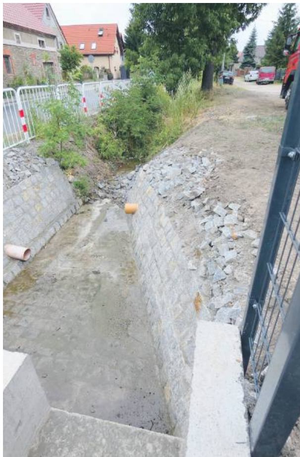
Tak wygląda odpływ z osadnika
