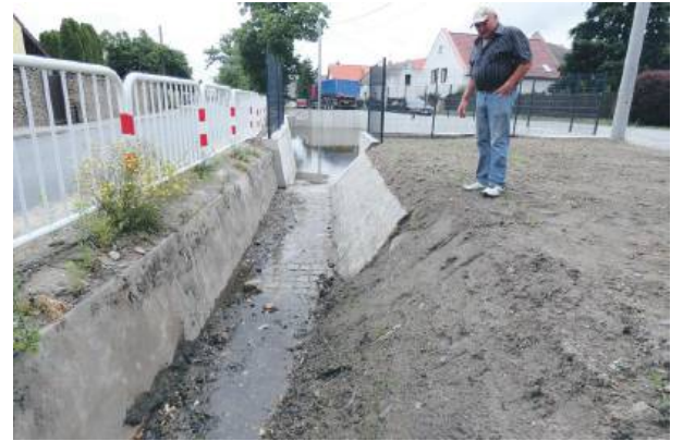
Rów i skarpa przed ujściem do osadnika
