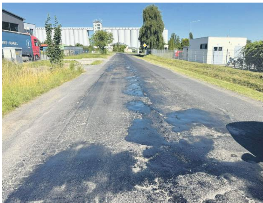
Z powodu upałów z drogi w Pęczu zaczęła wyciekać emulsja asfaltowa. Fot. Tadeusz Głowa
