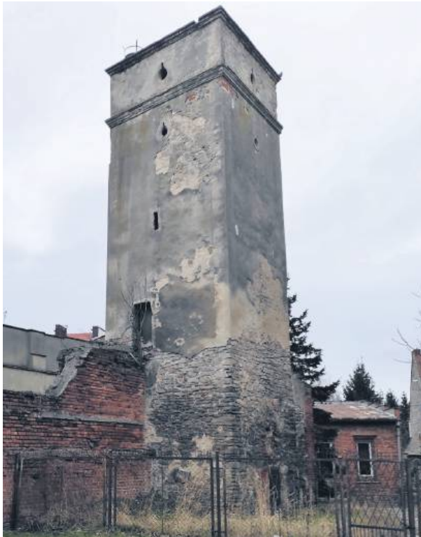
Remont, wraz z zabezpieczeniem Baszty Prochowej oraz przyległych murów, to jeden z wniosków, jaki gmina Strzelin zamierza złożyć w ramach rządowego programu odbudowy zabytków
