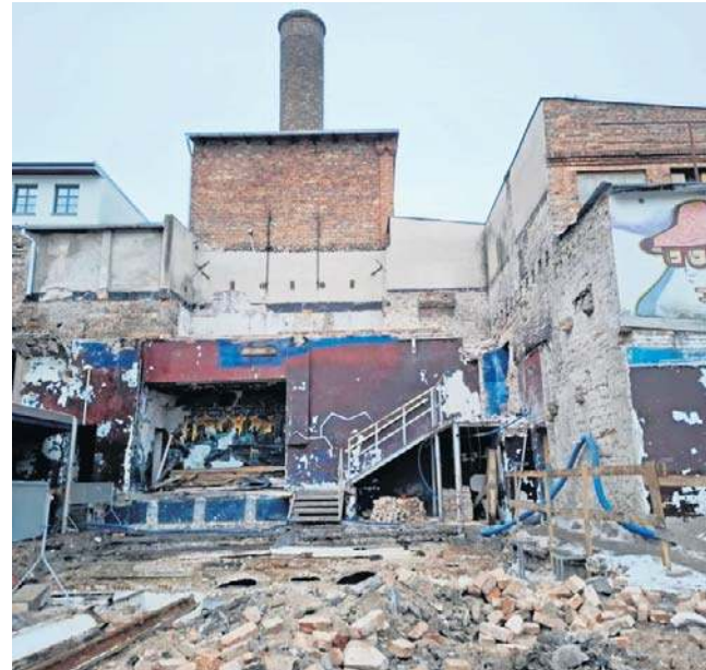
W Starym Browarze na starówce powstaje luksusowy hotel. Kolejny miesiąc trwają prace rozbiórkowe
