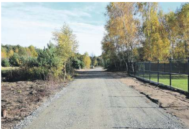
W Ozorowicach trwa przebudowa nawierzchni grunto-tłuczniowej na ulicy Osiedlowej
