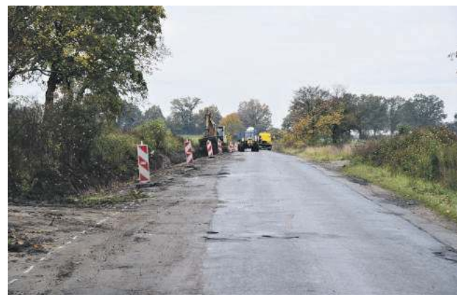
Rozpoczął się kolejny etap przebudowy drogi powiatowej nr 1367D (Strzeszów – Ozorowice)
