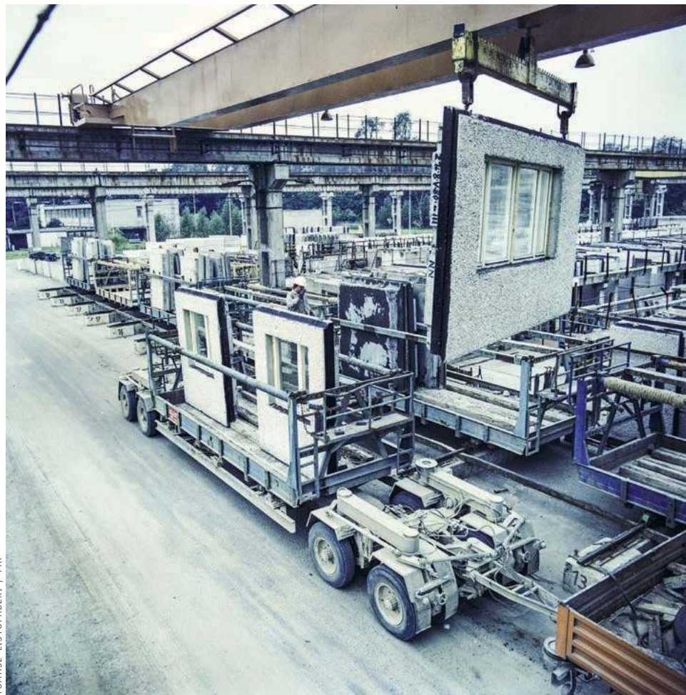
Produkcja domów z wielkiej płyty w Fabryce Domów na warszawskim Śłużewcu, dziś już niestniejącej, lipiec 1980 r.
