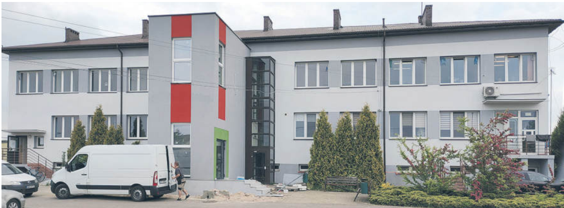
Remont budynku dobiega końca
