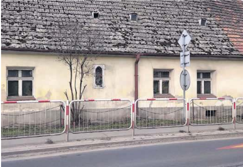
Od ponad 60 lat figurka Matki Boskiej stoi we wnęce budynku przy ul. Wrocławskiej w centrum Borka Strzelińskiego i czuwa nad rodziną pani Kazi
