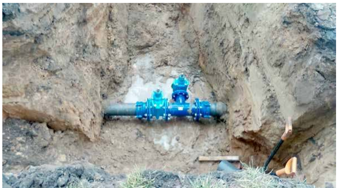
W ramach inwestycji wybudowany zostanie spory odcinek wodociągowy
