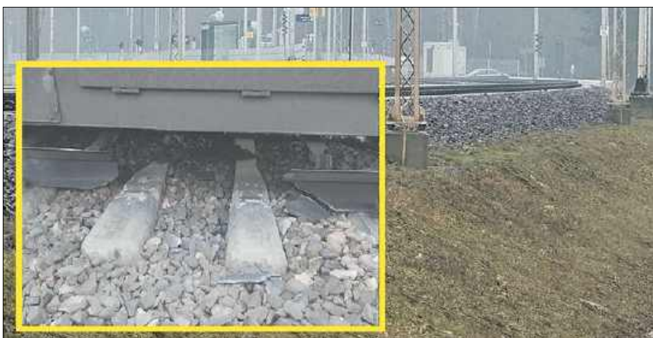
Pod przejeżdżającym przez stację Mika pociągiem zdetonowano ładunek C4. Eksplozja uszkodziła około metrowy odcinek szyny, jednak skład nie wykołcił się
