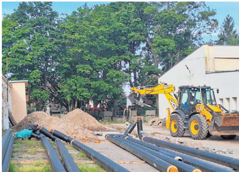
Rok temu toruńska sieć ciepłownicza była modernizowana między innymi na ulicy Dekerta, w otoczeniu Zespołu Szkół Technicznych
