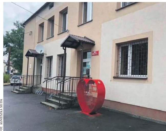
Serce stanęło pod sołtysówką w Gromcu.
