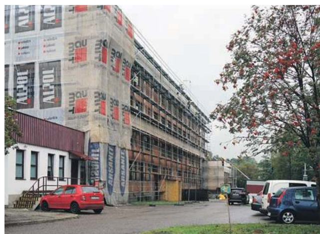
Rozpoczęła się termomodernizacja Urzędu Miejskiego w Alwerni
