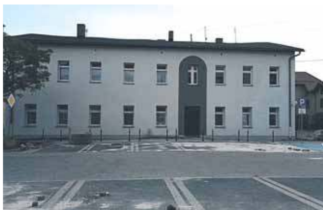
Tak po termomodernizacji wygląda dom przy ul. 1 Maja 3 w Kaletach
