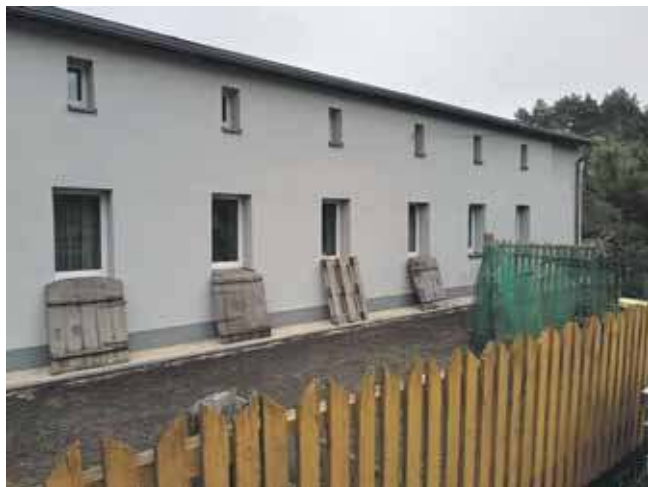
Poddany termomodernizacji dom w Truszczy
