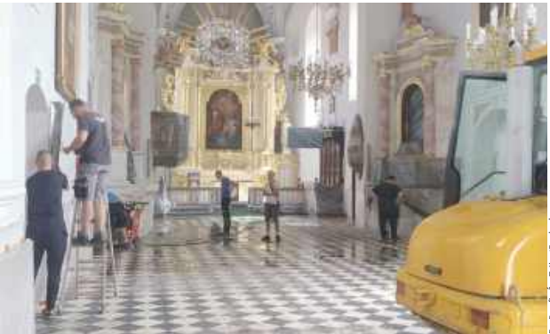
Inwestycja obejmuje wymianę posadzki w nawie głównej oraz montaż ogrzewania podłogowego
