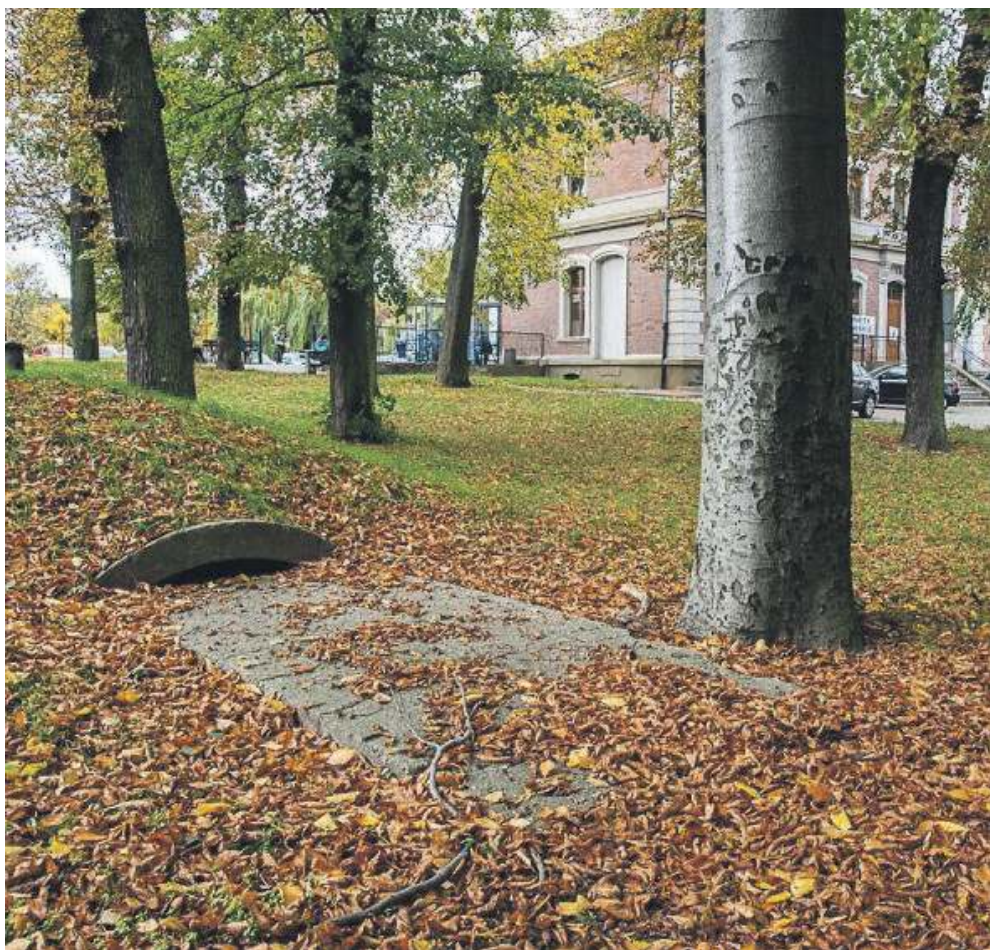
Wejścia do poniemieckich schronów zostały kilka lat temu zablokowane
