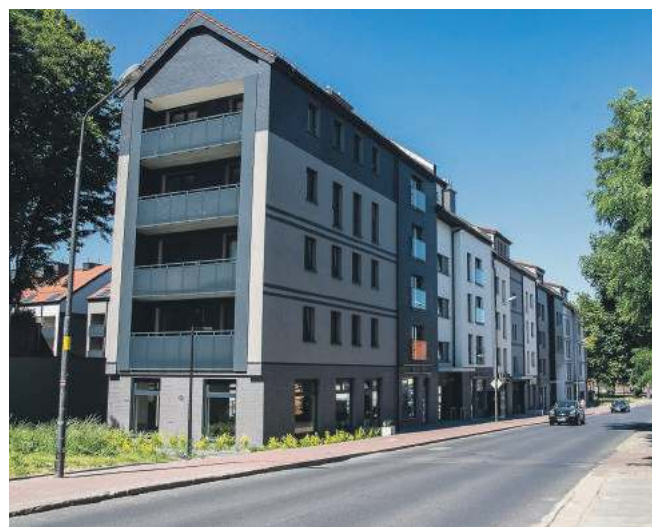
Doraźne schronienia znajdują się także w budynkach osiedla "Stara Mleczarnia"
