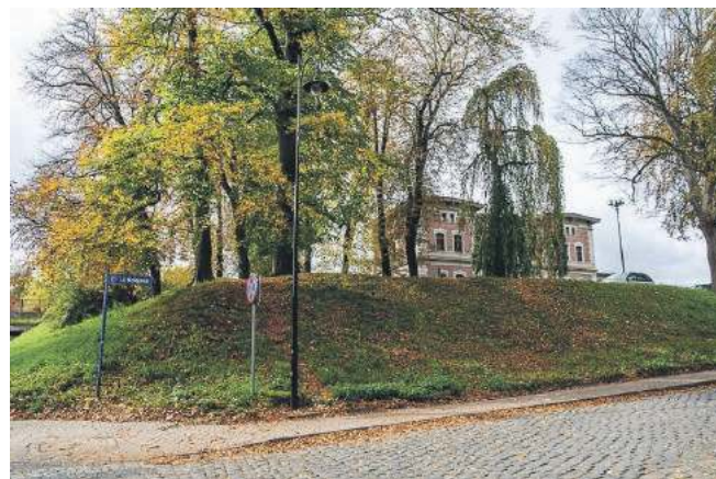
Dawne schrony przeciwlotnicze przy trzebnickim dworcu kolejowym zostały zakwalifikowane jako doraźne schronienia
