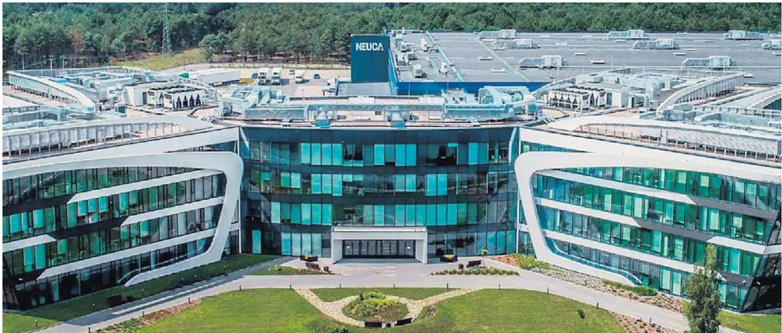
Główna siedziba spółki Neuca oraz jedno z jej centrów dystrybucyjnych od kilku lat funkcjonują przy ulicy Fortecznej w Toruniu
