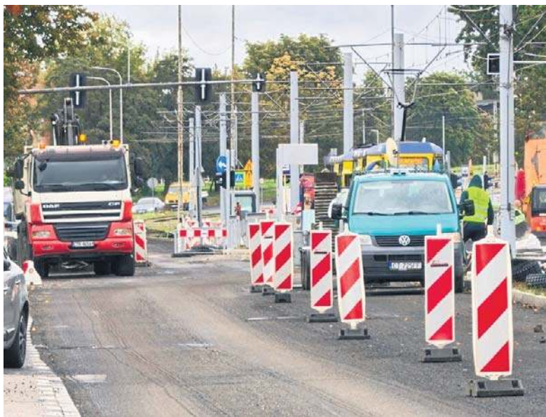
Na ul. Kościuszki sfrezowano nawierzchnię północnej jezdni
