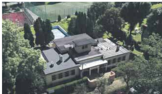
Atutem filmu są m.in. ujęcia z drona. Na tym widać PMDK im. H. Jordana czyli pawilon ogródka jordanowskiego. Ma charakterystyczną przybudówkę przypominającą mostek kapitański. Budowa zaczęła się w 1939 roku, prace przerwał jednak wybuch wojny. Zakończono je w 1945 roku
