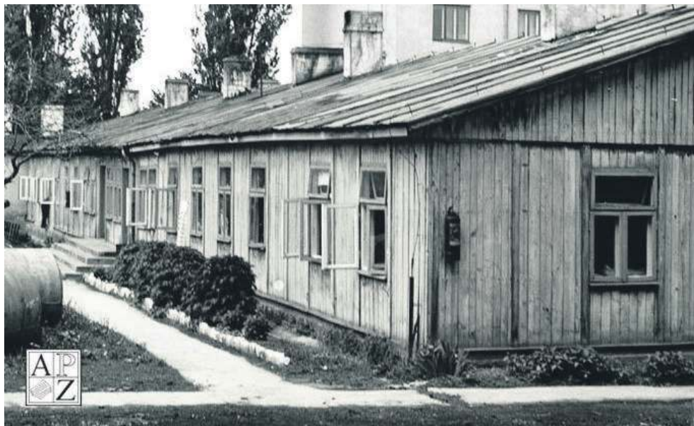
Lata 60. ub. wieku. Drewniany budynek oddziału zakaźno-gruźliczego zamojskiego szpitala. Został rozebrany w połowie lat 70. ub. wieku. Ze zbiorów APZ
