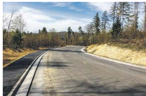
Nowa nawierzchnia na serpentynach na trasie Alwernia - Grojec
