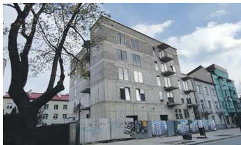
Budowa obiektu mieszkalnego przy Alei Henryka w Chrzanowie
