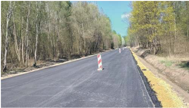
Nowy asfalt na ulicy Wodzińskiej wzdłuż osadnika ZG Trzebieńka
