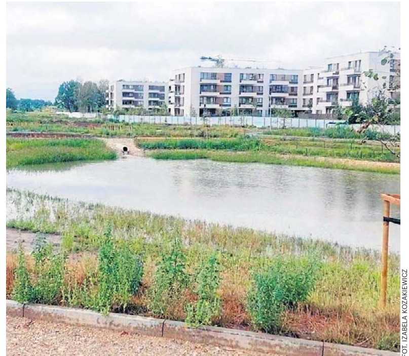
Budowa parku ze stawami na Wacynie w Radomiu stanęła. Po zerwaniu umowy z wykonawcą Wodociągi Miejskie szykują się do kolejnego przetargu na dokończenie prac.
