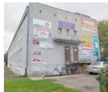
Pracownia tapicerska mieści się w pomieszczeniach piwnicy budynku RCP przy ul. Wojska Polskiego
