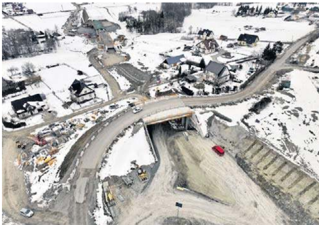
Nowy wiadukt drogowy w Kłodnem. Powstają nowe drogi, mosty i estakady
